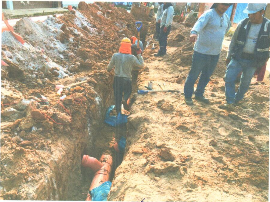
CONEXIÓN DOMICILIARIA DE DESAGUE EN LA CUADRA 4.
