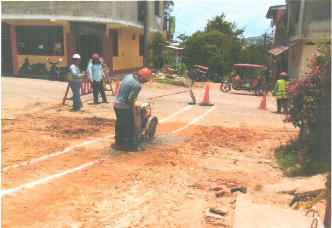
CORTE DEL PAVIMENTO EXISTENTE PARA INSTALACION DEL COLECTOR DE DESAGUE.
