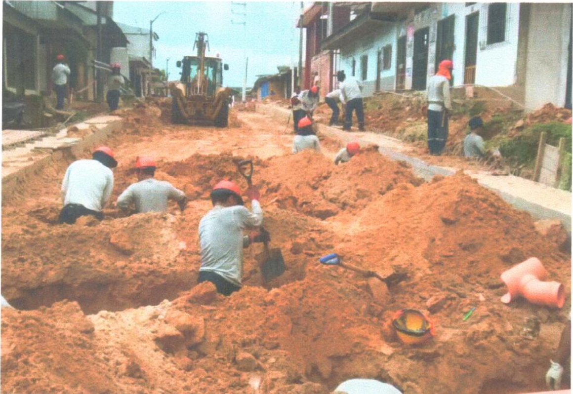
CONEXIONES DOMICILIARIAS DE DESAGUE EN LA C-8.
