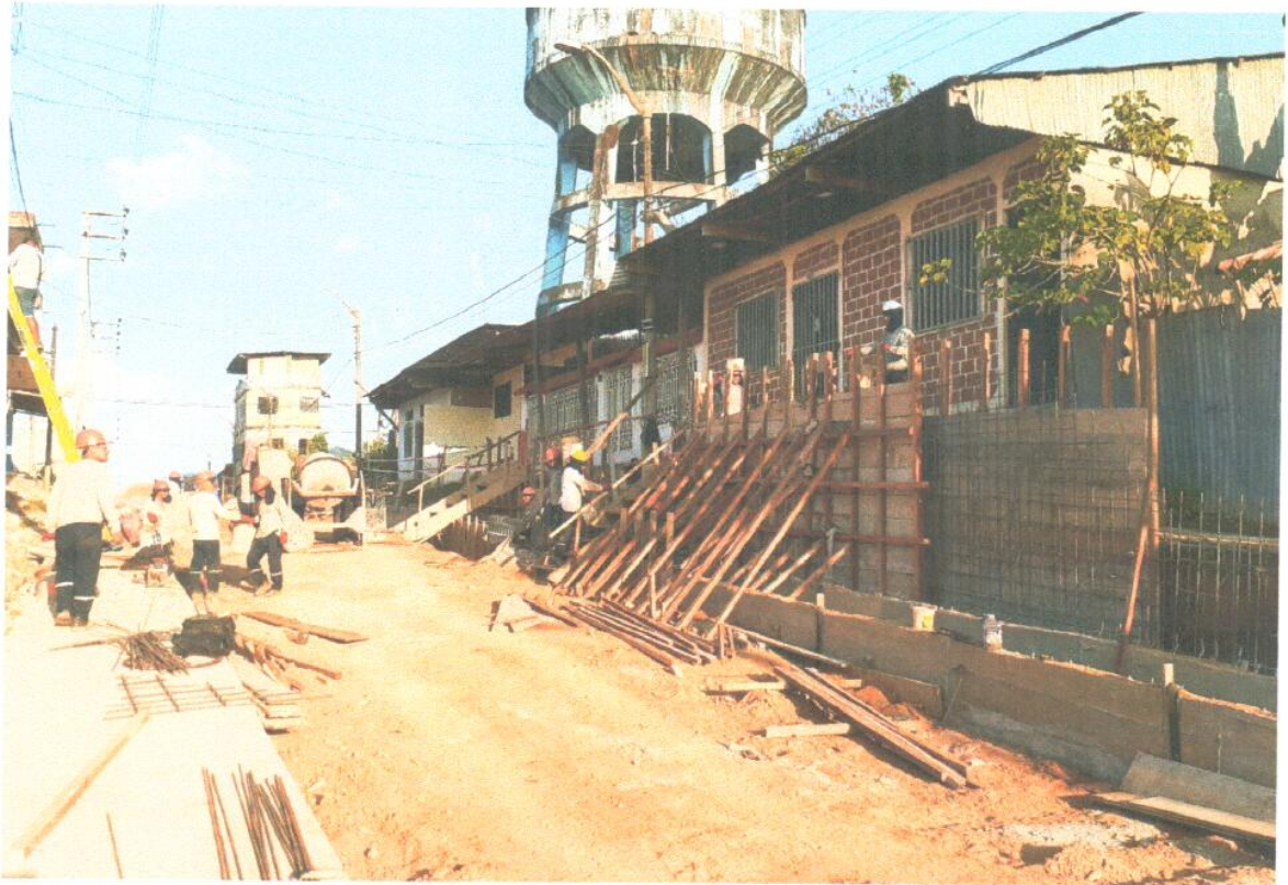
ENCOFRADO DE MURO DE CONTENCION N°8 EN LA CUADRA 5 FRENTE A LA PROGRESIVA 0+330.
