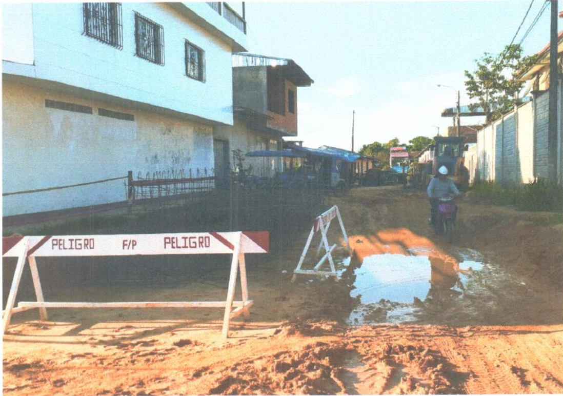
SEÑALIZACION FRENTE AL ALMACEN DE LA OBRA.
