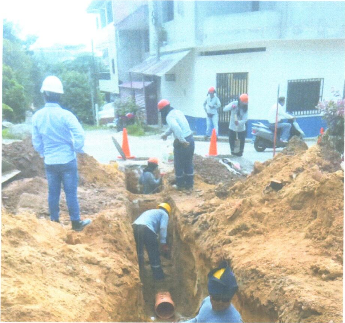
EMPALME DE COLECTOR EN BUZON EXISTENTE.
