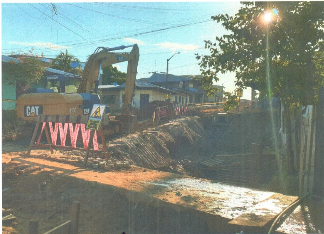
SEÑALIZACION FRENTE AL MURO DE CONTENCIÓN N°2
