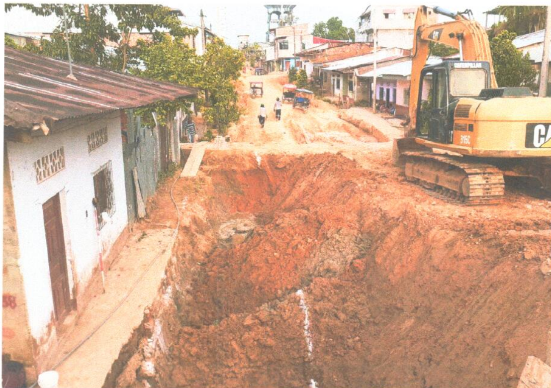
TRAZO Y EXCAVACION PARA ZAPATA DE MURO DE CONTENCION N°2 EN LA CUADRA 7.
